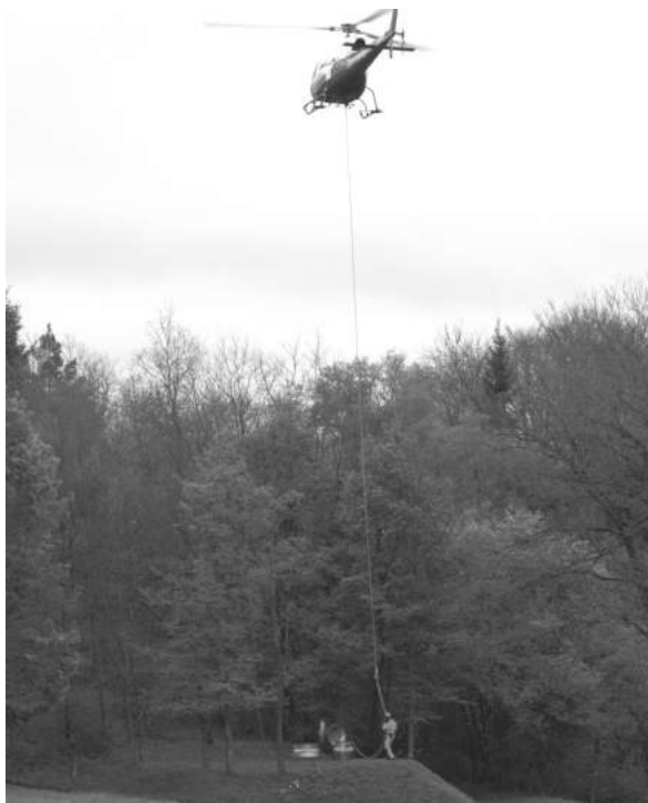
Intervention du 9 mai 2017, changement des pompes
