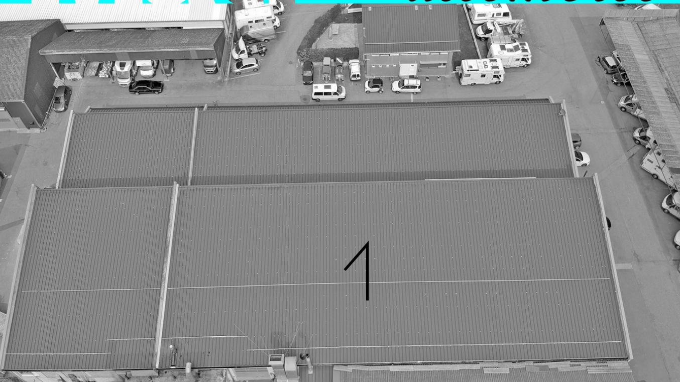
Toiture n° 1 de la parcelle 90
